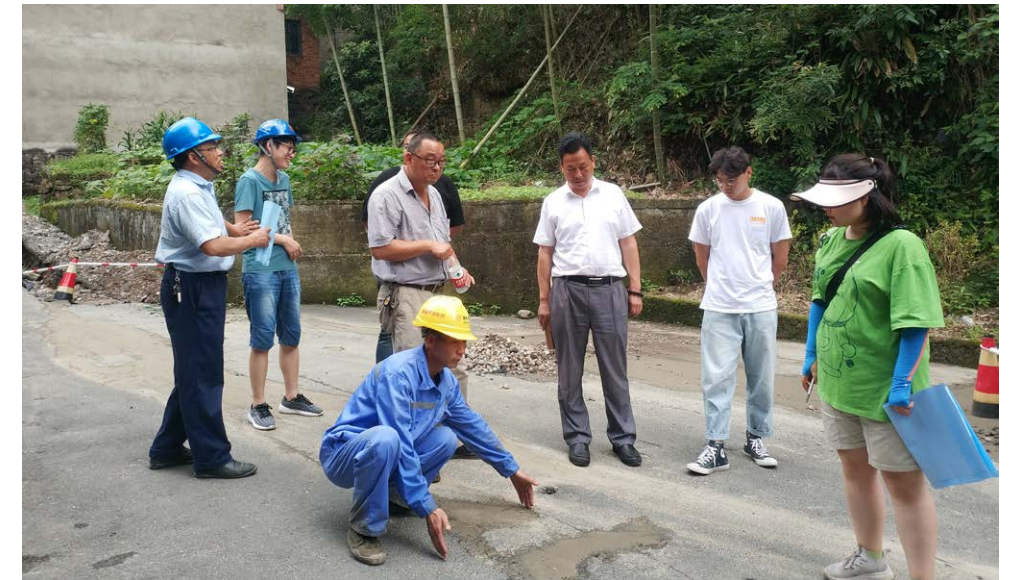
> 富阳公司开展振兴乡村燃气建设
