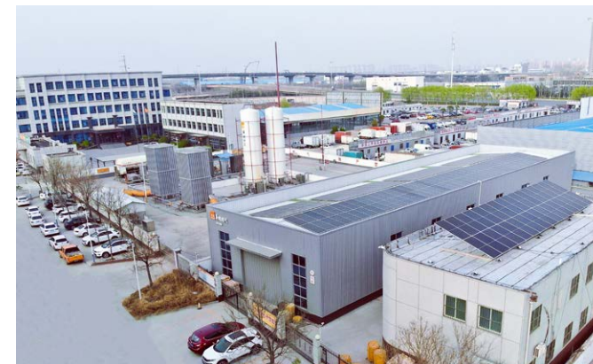
> 临沂公司仓库分布式光伏项目
